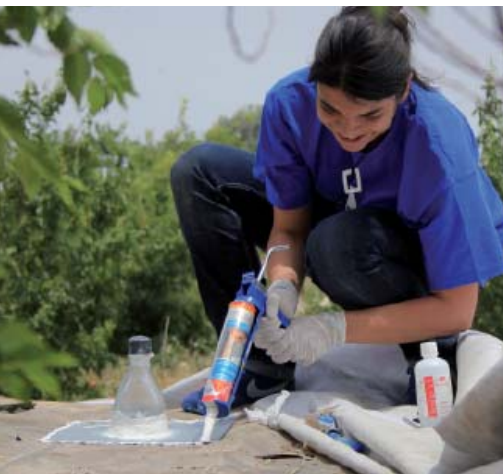
Önkéntes használja a Sikaflex® AT-Connection tömítőanyagot
