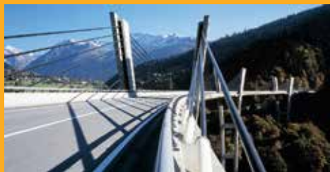
BETONVÉDELEM ÉS -HELYREÁLLÍTÁS
