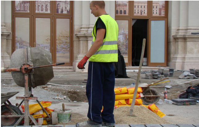
1. ábra Sika® FastFix-134 CZ és a megfelelő szemnagyságú és tömegarányú megfelelő ágyazási konzisztenciával zúzottkő összekeverése
