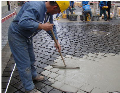
4. ábra Fugázó anyag felhordása, bedolgozása
