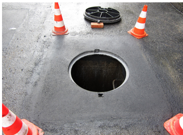
A Sika® FastFix-138 elsimítása, még a kikeményedés előtt.
