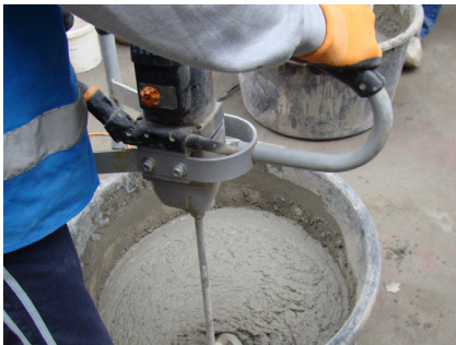
3. ábra Sika® FastFix-133 CZ és megfelelő mennyiségű víz összekeverése
