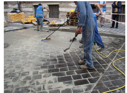
5. ábra A felület tisztítása pl. kisnyomású vizes berendezés alkalmazásával
