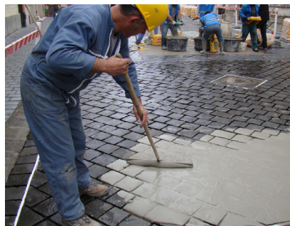
4. ábra Fugázó anyag felhordása, bedolgozása
