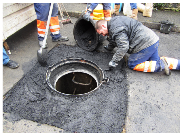
A Sika® FastFix-138 aknakeret köré történő bedolgozása - önhető konzisztenciával.
