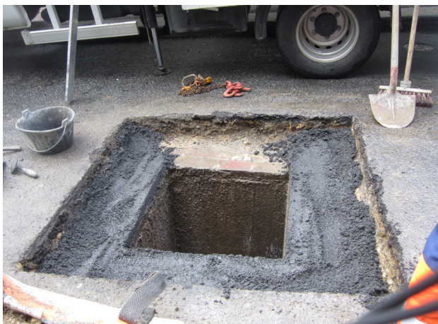
Sika® FastFix-138 ágyazóhabarcs állékony konzisztenciával bedolgozva. Az aknakeret végső szintjének beállítása.
