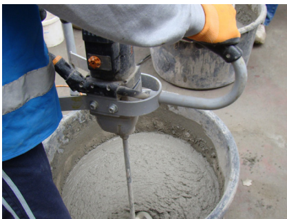
3. ábra Sika® FastFix-133 CZ és megfelelő mennyiségű víz összekeverése
