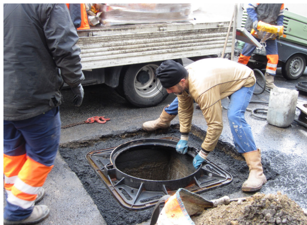
Sika® FastFix-138 ágyazóhabarcs állékony konzisztenciával bedolgozva. Az aknakeret végső szintjének beállítása.
