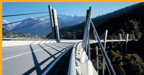
BETONVÉDELEM ÉS -HELYREÁLLÍTÁS
