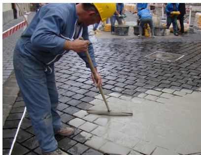
4. ábra Fugázó anyag felhordása, bedolgozása
