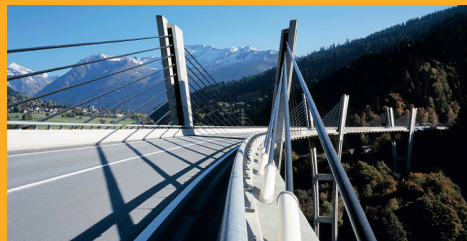
BETONVÉDELEM ÉS -HELYREÁLLÍTÁS
