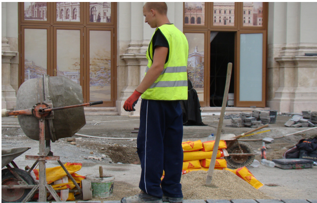
1. ábra Sika® FastFix-132 és a megfelelő szemnagyságú és tömegarányú megfelelő ágyazási konzisztenciával zúzottkő összekeverése
