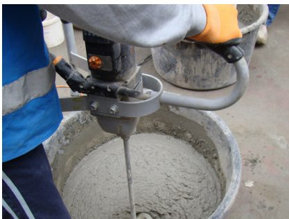
3. ábra Sika® FastFix-133 és megfelelő mennyiségű víz összekeverése
