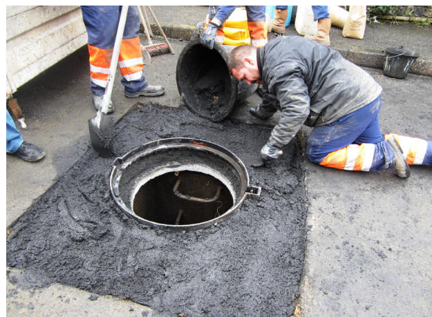
A Sika® FastFix-138 aknakeret köré történő bedolgozása - önthető konzisztenciával.
