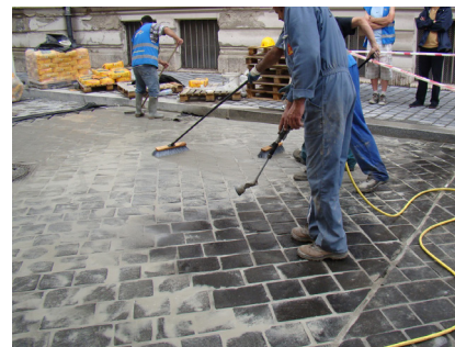
5. ábra A felület tisztítása pl. kisnyomású vizes berendezés alkalmazásával
