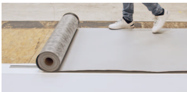
3. Új Sarnafil® FPO tetőszigetelő lemez pozícióba állítása.
