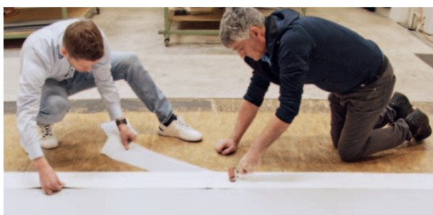
1. A SikaRoof® Multitape szalag feldolgozása a meglévő szintetikus vagy bitumenes tetőszigetelő lemezre.
