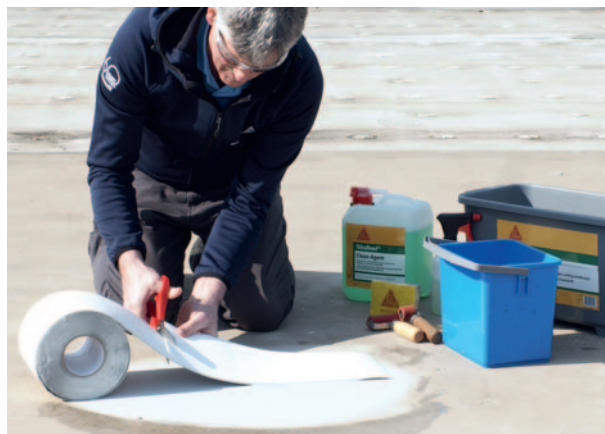
6. Vágja le SikaRoof® Multitape szalagot a szükséges hosszban.
