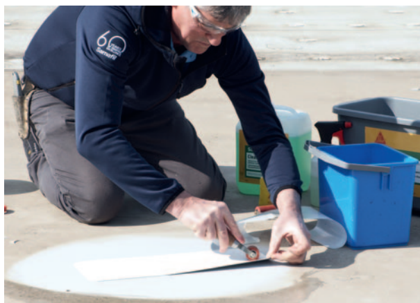
8. Ragassza le a SikaRoof® Multitape szalagot nyomóhenger segítségével.
