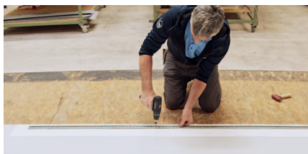
2. Sarnabar® rögzítőcsín beépítése Sarnafast® rögzítő csavarokkal és Sarnafil® T Welding Cord hegesztőszinórral.
