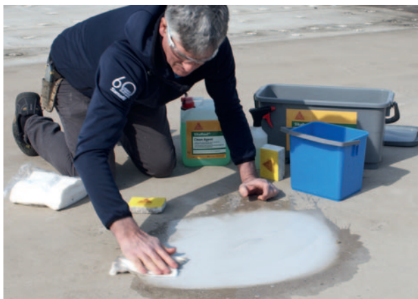
5. Tisztítsa meg alaposan a javítandó felületet (ld. TISZTÍTÁS).
