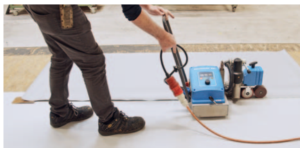
4. Sarnafil® FPO szigetelőlemez forrólevegős hegesztett varratának elkészítése automatával a SikaRoof® Multitape szalagra.
