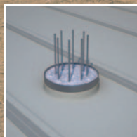
SikaProof® részlet- képzés megoldások, pl.: cölöpfejekhez
