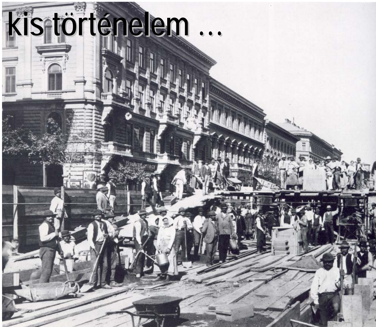
A földalatti vasút építése az Andrásy úton; 1894. szeptember (Forrás: Budapest Anno ..., Bp 1979 Corvina Kiadó)
