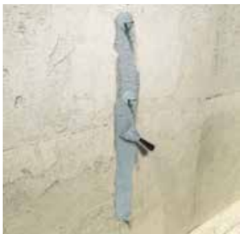
Repedés tömítése.
