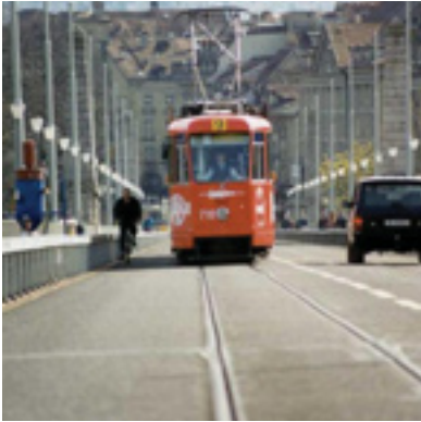
Bern, Németország. Kornhausbrücke (folytonos sínágyazás, teljes kiöntés, Ri 51 vályús sín)
