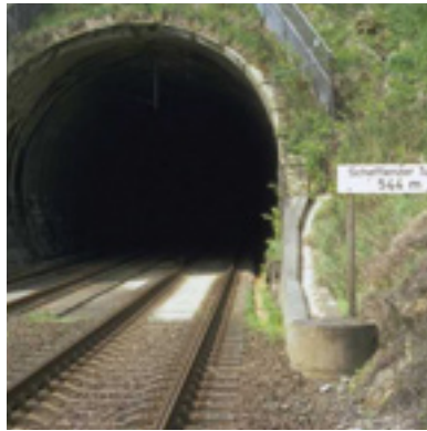
Mosbach, Németország. Schefflenzer alagút (IOARV 199 rendszerű sínleerősítés)
