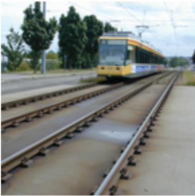
Karlsruhe, Németország. Híd a Siemensallee környékén (Sínleerősítés csak ragasztva, Rph 1 típusú alátétlemez, 345 × 210 mm)
