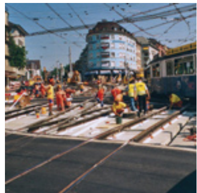
Zürich, Svájc. Schaffhauser tér (kiöntési munkálatok, Ri 53 vályús sín)
