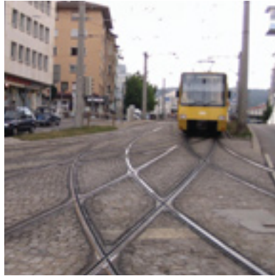
Stuttgart, Németország. Berliner Platz (folytonos sínágyazás, teljes kiöntés, Ri 60 vályús sín)
