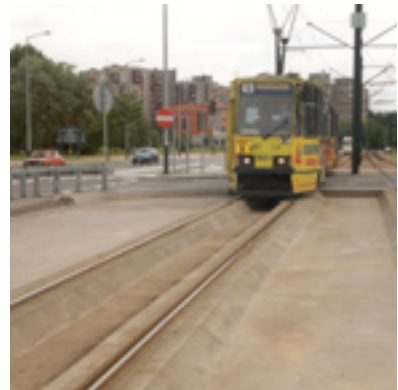
Krakkó, Lengyelország. Izidor Stelli-Sawickiego híd (folytonos sínágyazás, teljes kiöntés Ri 60 vályús sín)
