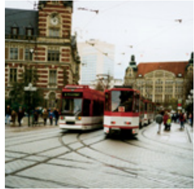
Erfurt, Németország. Főtér. A rázkódási, vibrációs hatást az Ri 60 vályús sín folytonos ágyazása, teljes kiöntése pontosan 40%-kal csökkentette
