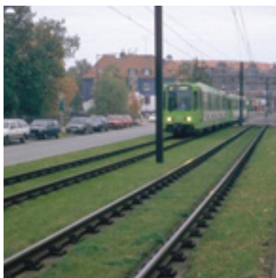
Hannover-Langenhagen, Németország. Vahrenwalder Strasse (pontoszerű leerősítések hosszgerendákon)
