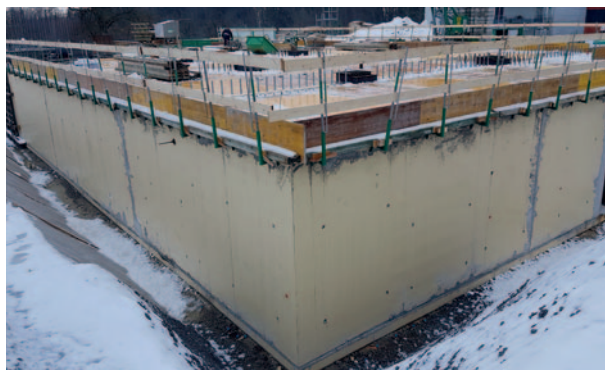
Nyitott munkatér SikaProof® A+ szigeteléssel: A zsaluzat eltávolítása után az átkötő csavarok helyét tömíteni kell.
