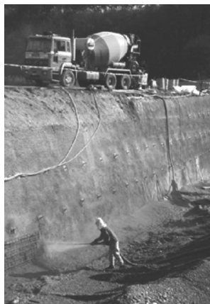
18. fotó: Munkagödör partfal megtámasztása lőtt betonnal
