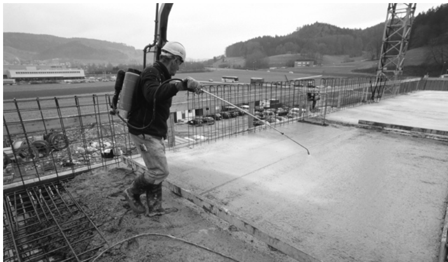
23. fotó: Utókezelőszer felhordása frissen simított betonfelületre
