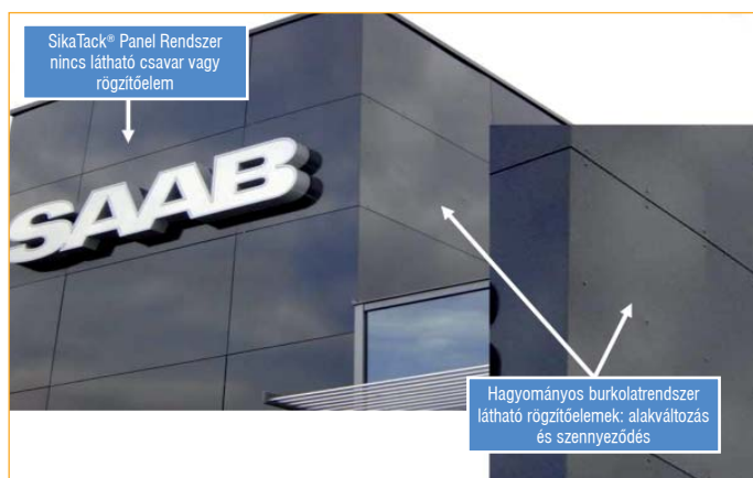
Burkolatragasztás PU-ragasztóval
