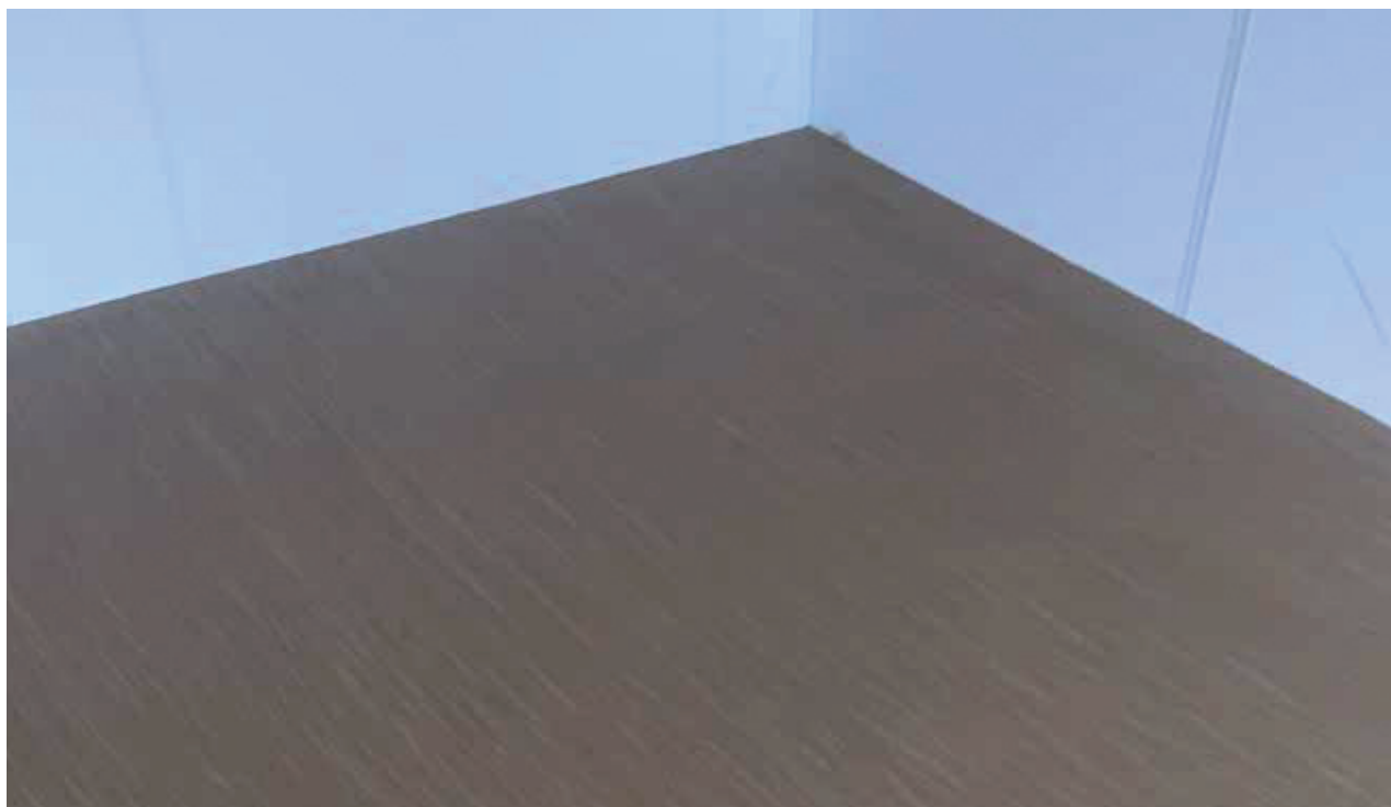
Speciális fogazott simító segítségével a fa erezetére hasonlító mintázat hozható létre.
