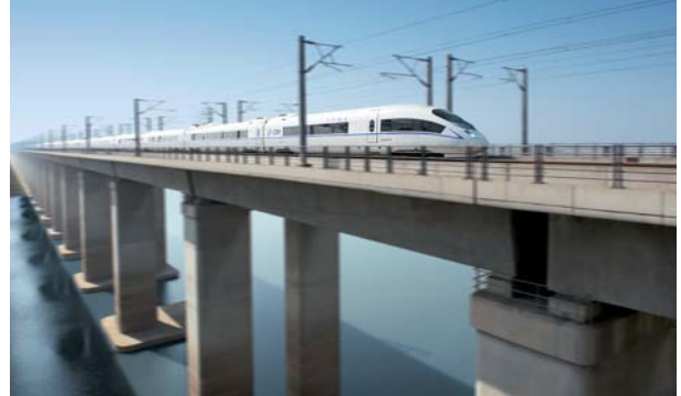
BETONJAVÍTÁS ÉS SZERKEZETMEGERŐSÍTÉS
