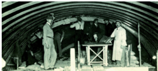
Az első Gotthard vasúti alagút vízszigetelése
