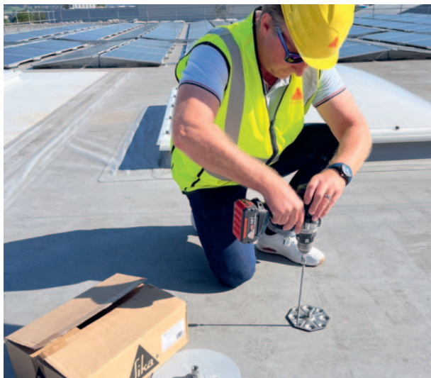
Sarnafast® Fastener SBF-6.0 csavar, vagy Sarnafast® Fastener SBF-6.0 csavar Sarnabar® Tube SBT-20 dübellel.
