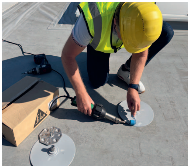
SikaRoof® Anchor 250 mm CR szigetelő karima rácsavarozva a SikaRoof® Anchor 140 mm-es alátételre, ezt követően forrólevegős hegesztett kapcsolat kialakítása a tetőszigetelő lemezhez.
