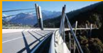
BETONVÉDELEM ÉS HELYREÁLLÍTÁS
