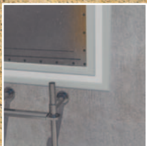
Csatlakozási hézag beton-acél
