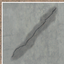
Szivárgó repedések
