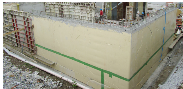
Nyitott munkatér SikaProof® A szigeteléssel, a zsaluzat átkötő csavarjainak helyét tömíteni kell miután eltávolítottuk a zsaluzatot.
