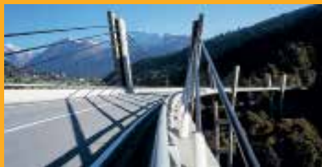
BETONVÉDELEM ÉS -HELYREÁLLÍTÁS
