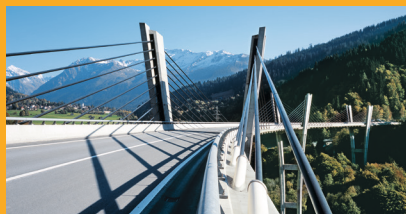
BETONVÉDELEM ÉS -HELYREÁLLÍTÁS
