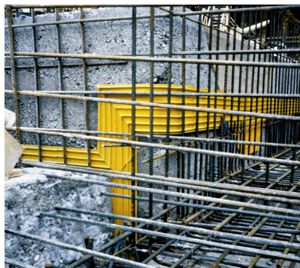
2. ábra: Sika PVC fugaszalagok beépítve Rugalmas kialakításúak és megakadályozzák a víz átjutását, ezáltal biztosítva a hézagokban mind a vízzáróságot, mind a mozgás lehetőségét alacsony és magas víznyomás esetén is.
