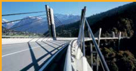
BETONVÉDELEM ÉS -HELYREÁLLÍTÁS
