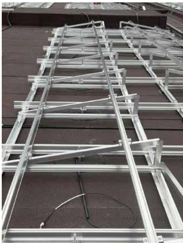
Elkészült napelemrögzítő tartószerkezet.
