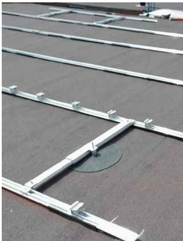
A SikaShield® Anchor és a napelem-rögzítőrendszer beépítése.
