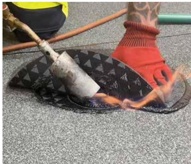
Zárólemez feldolgozása lángolvasztással.
