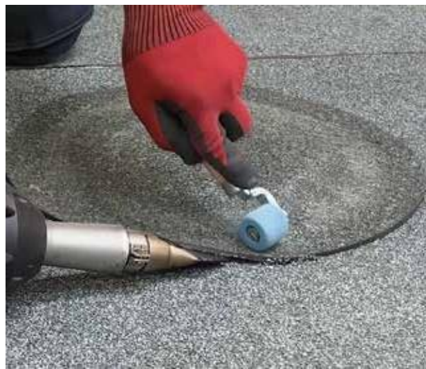
Zárólemez feldolgozása forrólevegős hegesztéssel.
