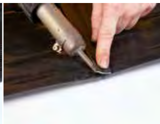
Megerősítés hegesztőszalaggal hőlégfúvó alkalmazásával
