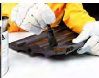
Vulkanizáló oldat felhordása a gumi felületére
