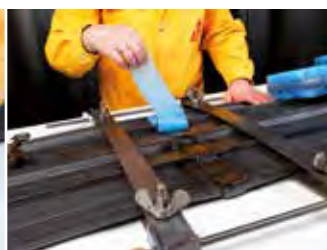
Fugaszalagok összeillesztése, ideiglenes megfogással
