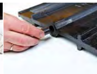
A dilatációs elem betömése habdugóval, majd nyers gumidugó beillesztése
