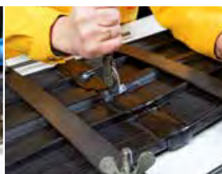
Tömítőszalag illesztése és mindkét tömítőszalag összenyomása
