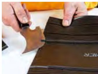
Átlapolás előkészítése
