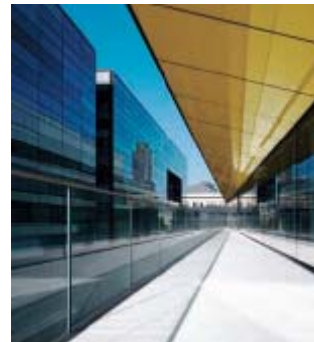
SikaForce® munka közben: láthatatlanul rögzített üveg mellvéd
