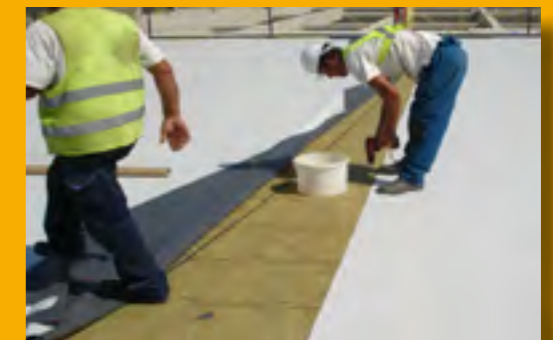
Kivitelezés közbeni helyszíni ellenőrzések
