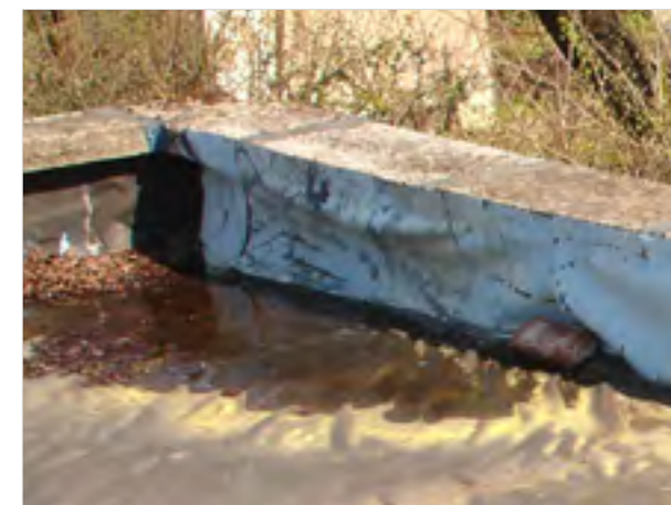
Az anyagzsugorodás által okozott kár. A nem megfelelően kiválasztott alapanyag miatt
