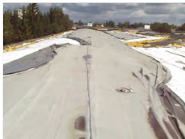
A vihar által okozott kár. A nem szakszerűen rögzített vízszigetelés miatt
