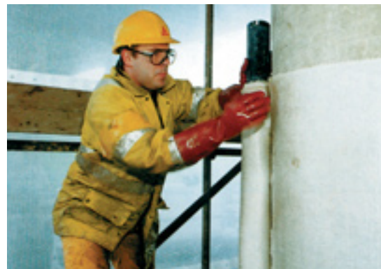
SikaWrap® szövetrendszer alkalmazása oszlop megerősítésére
